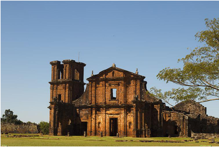
Figura 1. Igreja nas Ruínas de São Miguel Arcanjo. Fonte: Internet
