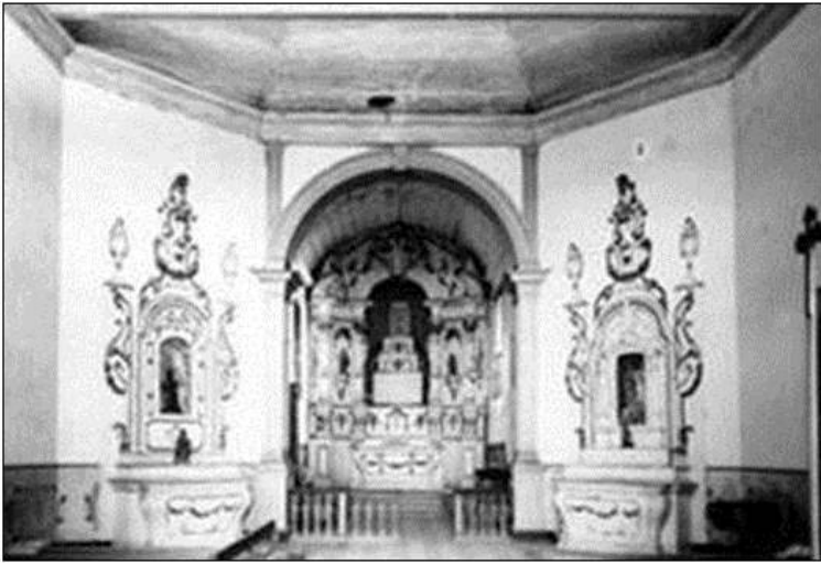
Figura 14. Foto interior da Capela, de 1940 – Capela-mor, altar e retábulos laterais. Fonte: Arquivos do IPHAN, SP.
