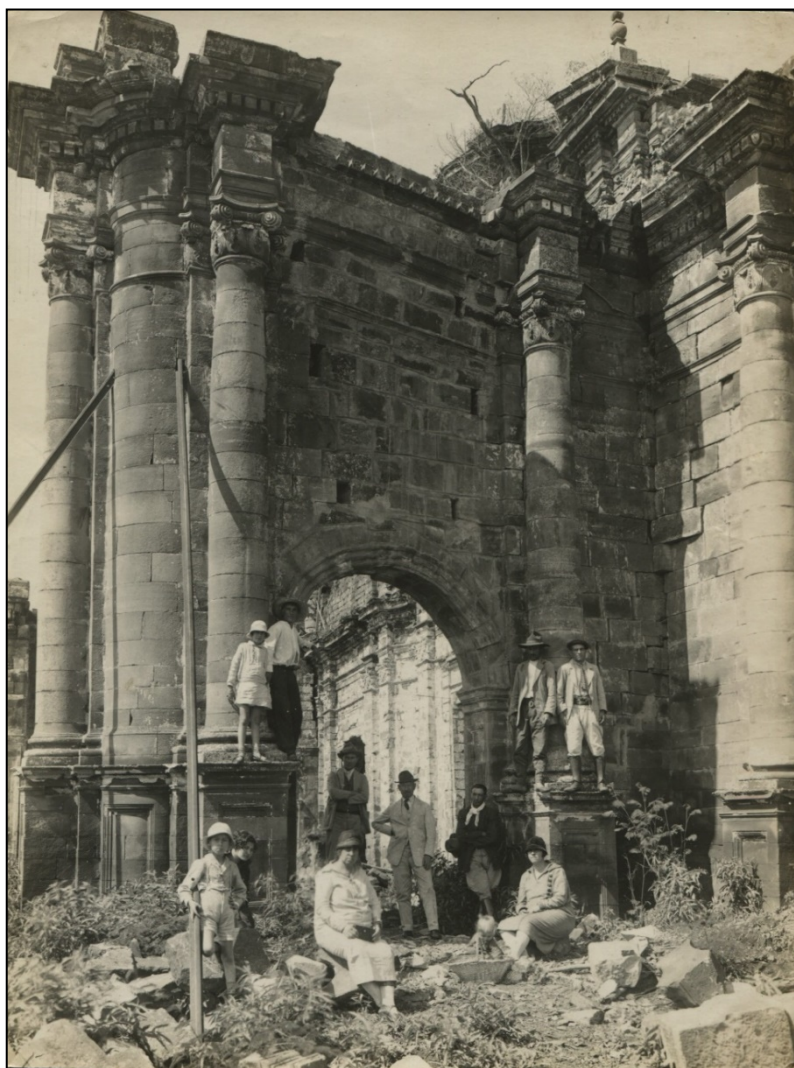
Figura 3. Populares na lateral da fachada das ruínas durante as obras de 1925-1927. Fonte: Acervo do Arquivo Central do IPHAN-Rio de Janeiro.
