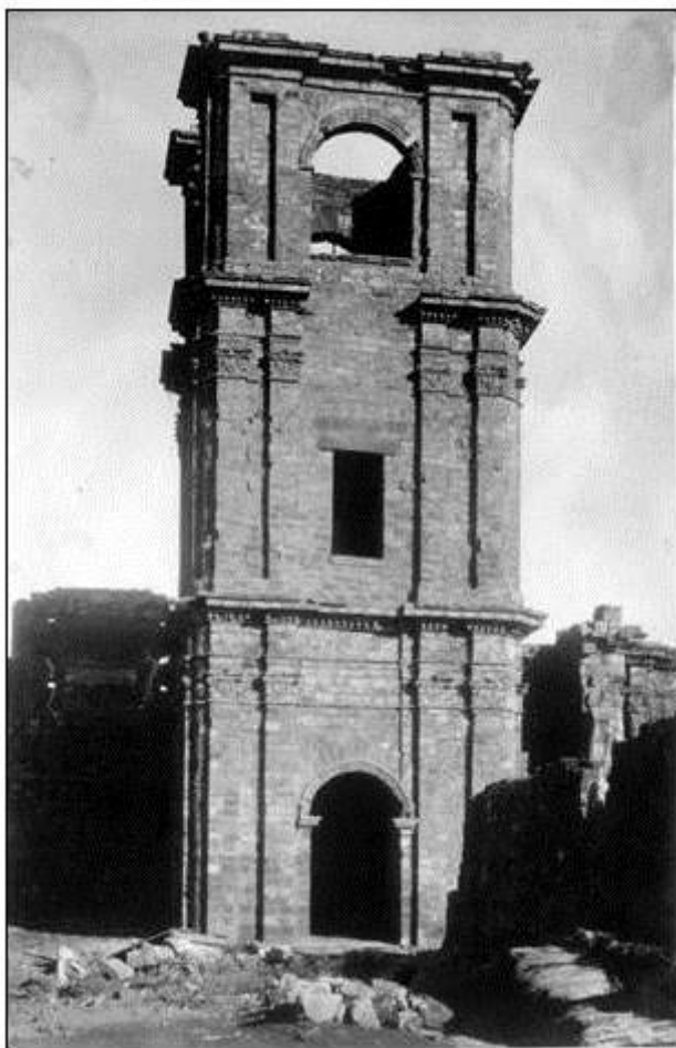
Figura 14. Resultado da estabilização da torre, lado leste, sem a segunda cimalha (1939-1941). (Arquivo Noronha Santos).
