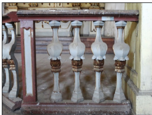
Figura 9. Foto detalhe cancelo em madeira policromada, sob arco do cruzeiro, separando a nave da capela-mor. Fonte: Arquivos do IPHAN, SP.
