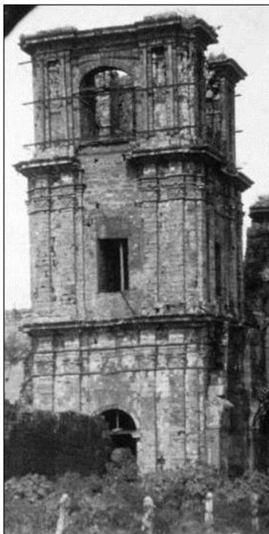
Figura 4. Obras de amarração parte superior da torre (Arquivo Noronha Santos).
