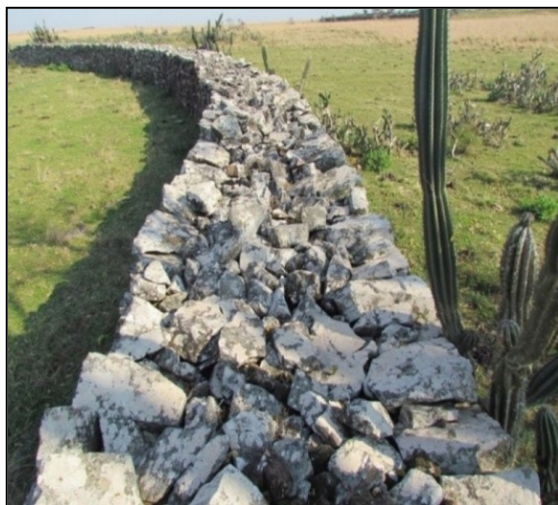
Figura 12. Muro do curral circular no espaço de manejo de gado – Estância São José.
