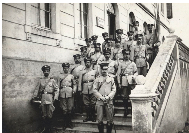
Grupo de guardas municipais em frente à antiga sede da Intendência Municipal (desde 1975 funciona o Museu Municipal). Caxias do Sul, 1920.
