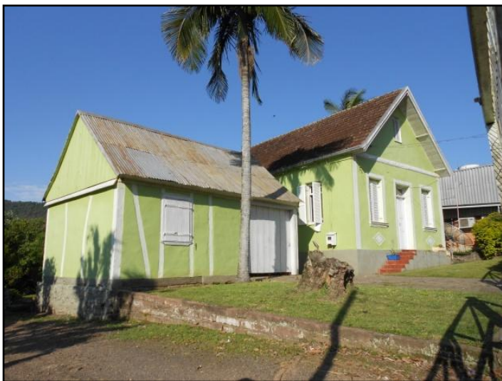
Figura 9: Edificação à direita abrigou a sub- prefeitura. Construção enxaimel à esquerda sofreu alterações nas aberturas. Foto: Acervo pessoal da autora.
