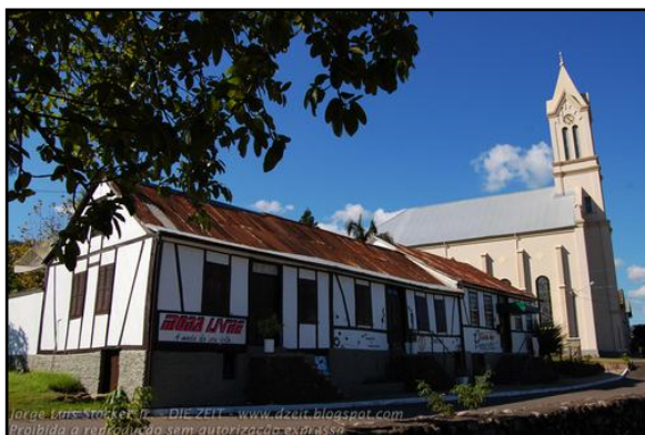
Figura 4: Antigo armazém e moradia de Balduino Schmidt, importante exemplar na técnica enxaimel e que faz conjunto com a igreja.
