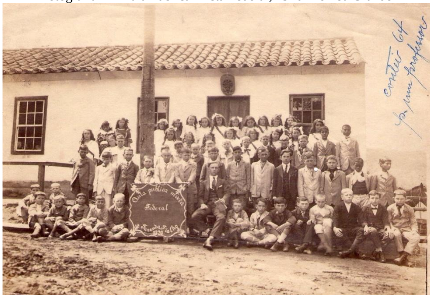
Fotografia 2 – Aula Pública Mista Federal, 1920- Lomba Grande
