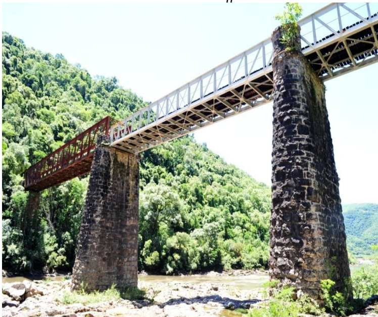
Ponte do Korff
